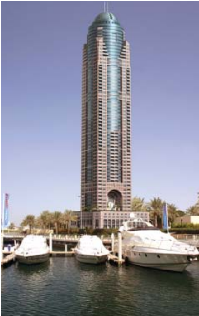
الشكل الذي سيبدو عليه مبنى «الإمارات للشقق» فور اكتماله.
